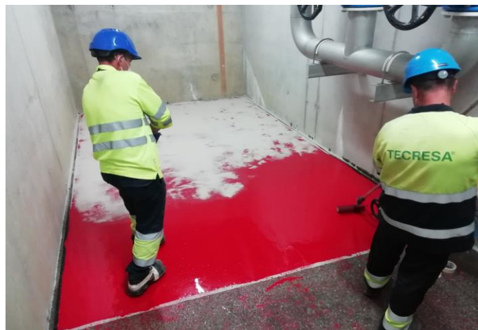
EDAR Este. Sistema MasterTop 1220 B capa base y sellado
