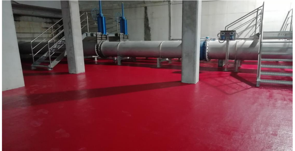
EDAR Este. Sistema MasterTop 1220 B terminado
