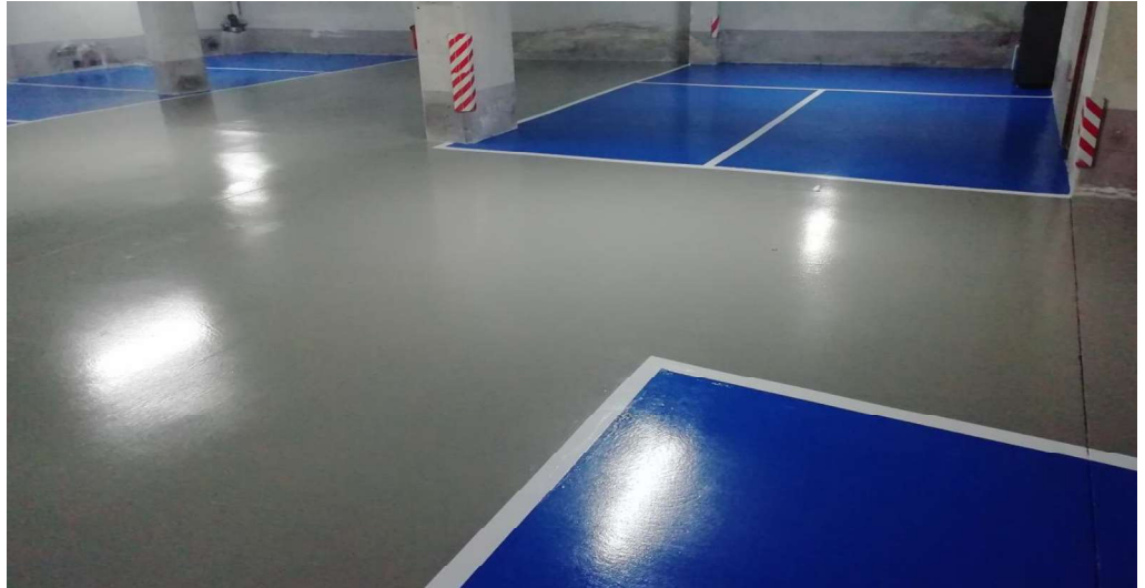
Sistema MasterTop 1728 sellado con MasterTop TC 448 con microesferas
