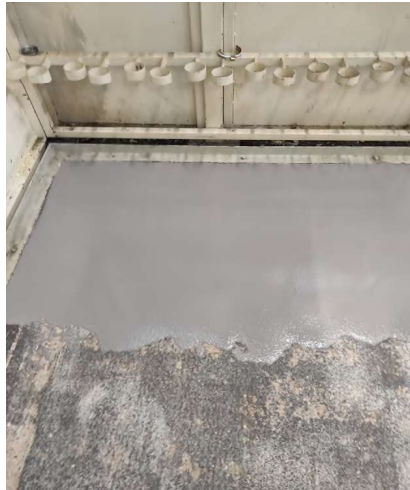
Diferentes pasos de la aplicación del pavimento una vez descontaminado y adecuado el soporte.
